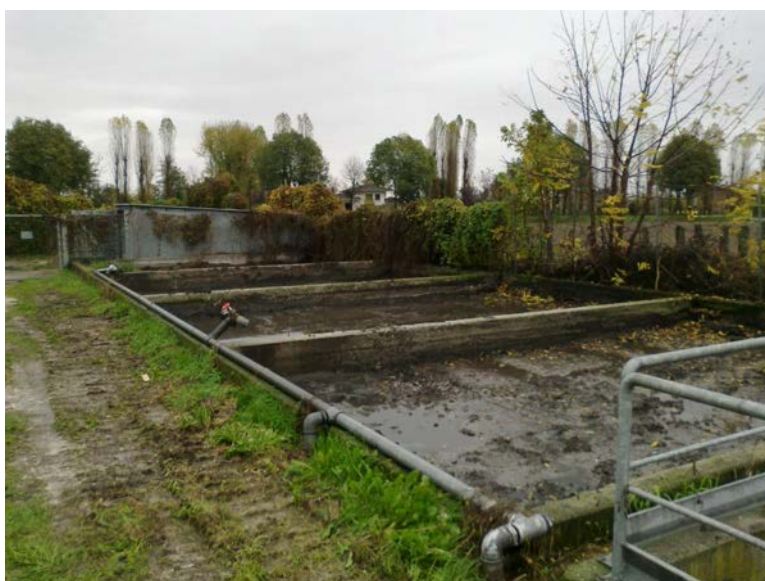
Figura 15 - Letti di essiccamento fanghi
