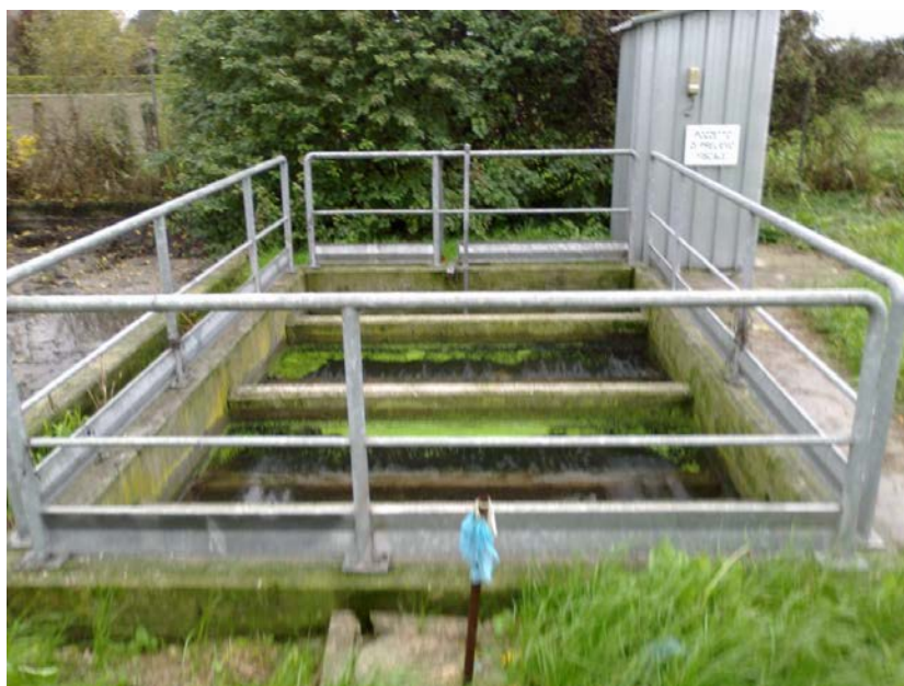
Figura 13 - Vasca di contatto - disinfezione finale
