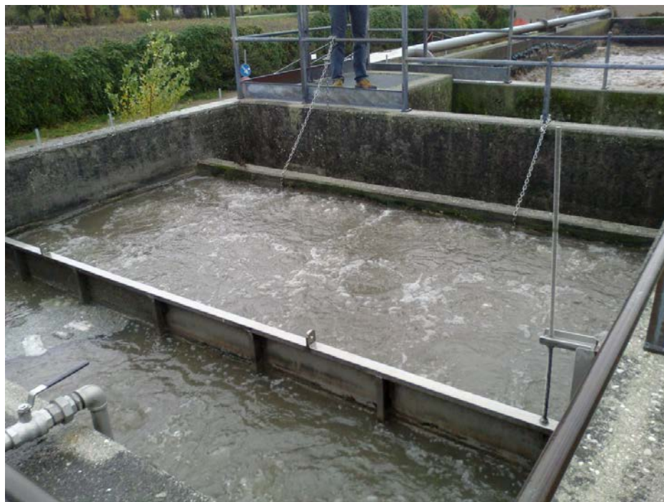
Figura 5 Dissabbiatura e disoleatura
