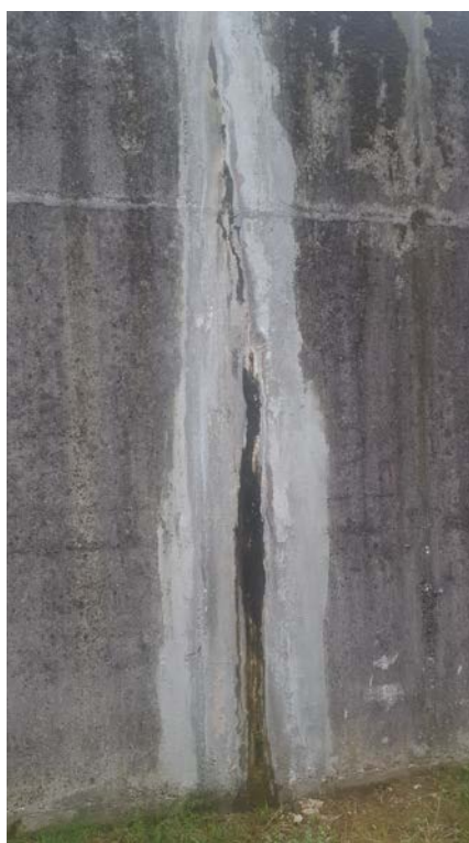
Figura 9 - Vasca di ossidazione - calcestruzzo ammalorato
