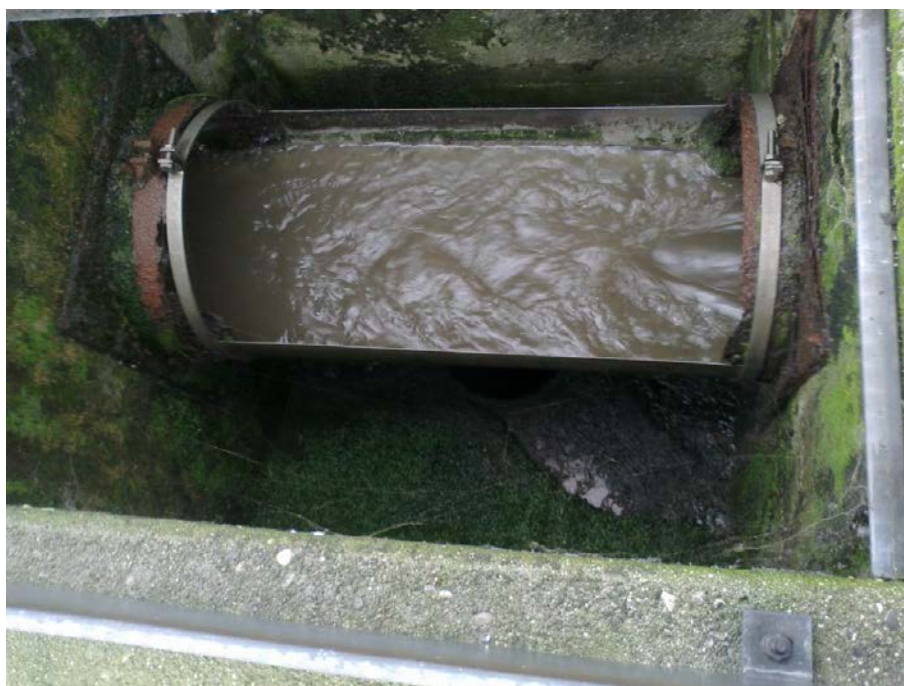
Figura 6 - By-pass impianto da 3Qmn a 2Qmn
