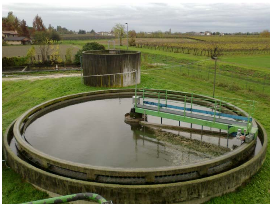
Figura 11 - Sedimentatore secondario
