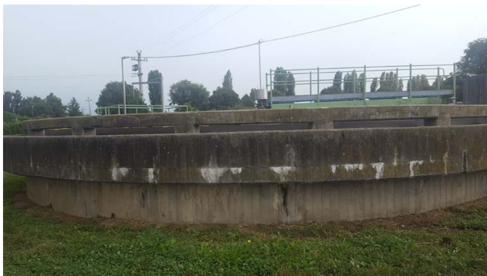
Figura 12 - Sedimentatore secondario - calcestruzzi ammalorati
